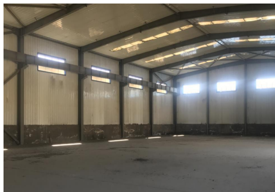
项目区南侧现状为钢结构厂房
