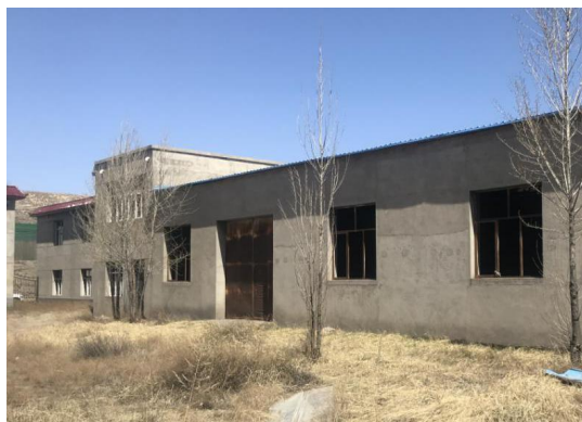
项目区东侧现状为2#厂房
