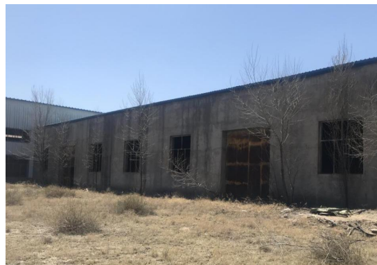
项目区西侧现状为厂房及原有锅炉房
