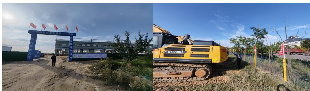
上图为原挖掘机停放场地，已开始施工。 上图为该公司同型号挖掘机
